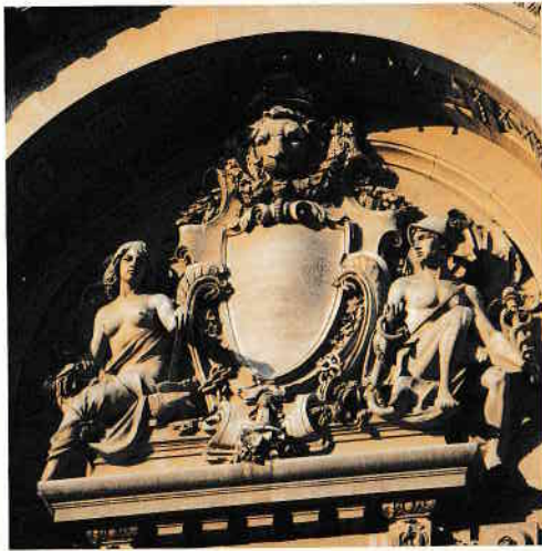
Detaliu de pe fațada Bibliotecii Naționale (1912, arh. Ștefan Burcuș), fostul Palat al Bursei de Valori
